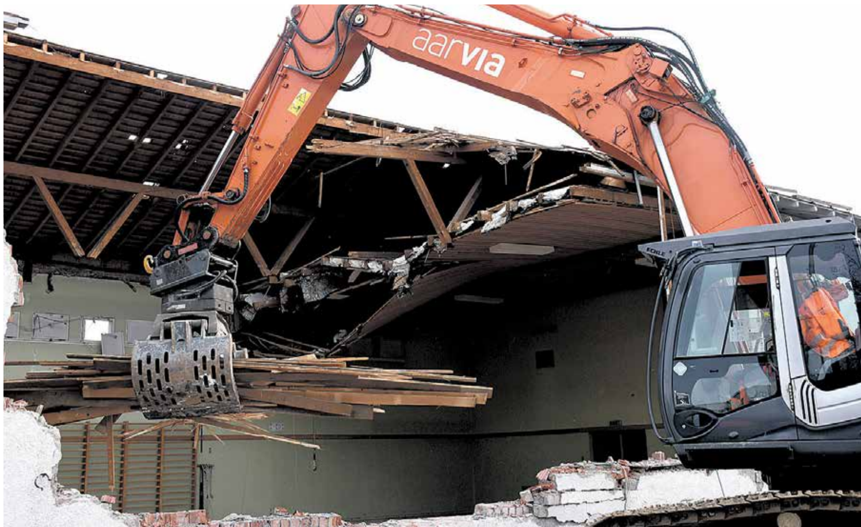
Die Abbrucharbeiten an der alten Turnhalle sind voll im Gange.
