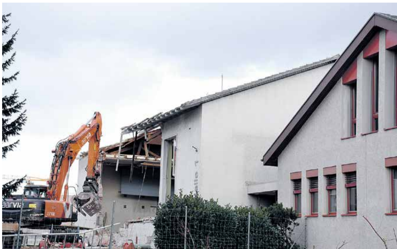
Das Schwierige beim Abbruch ist, dass die Kellerräume und das Verwaltungsgebäude nicht beschädigt werden.
